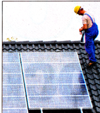
Ein Mitarbeiter der Firma Laue montiert Solar-Kollektoren auf dem Haus Block IV.
